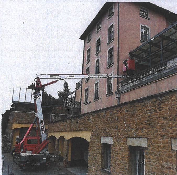
Le vitrage du plafond de la verrière a déjà été posé
